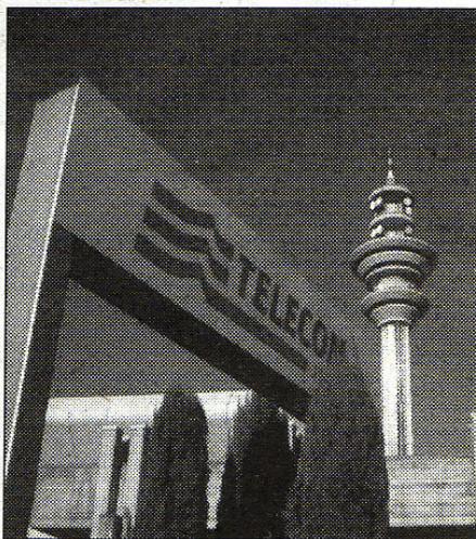
La sede Telecom di Catanzaro
